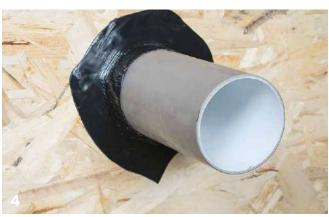
SEALING OF JOINT IN THE GROUND CONNECTION NODE
