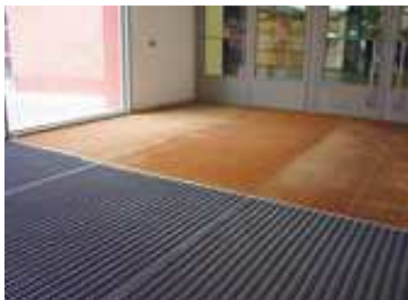
Nútímalistasafnið í Stokkhólfi. Kabe Original ásamt Kabe kókosmottu.
